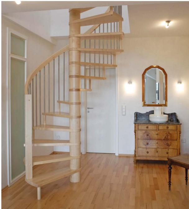
Die Stufen der Spindeltreppe treten aus einer mittigen Spindel heraus. Zwischen den einzelnen Stufen befinden sich außen Abstandshülsen.
